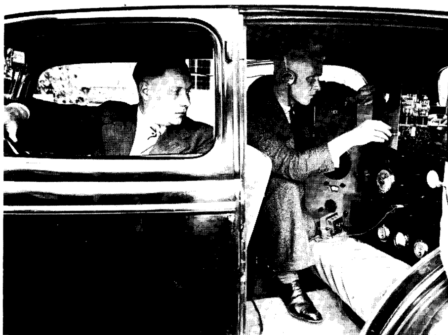
Foto 4. Zelfs ontvangst van beeld en geluid in een rijdende auto bleek mogelijk. Hier ziet u de ontvanger van foto 3 in een auto opgesteld, samen met een geluidsontvanger. De voedingsspanning van het geheel kwam uit een generator voor 220 volt. De man achter het stuur is waarschijnlijk OM Groeneheide uit Zoetermeer. (Alle foto's in 1938 gemaakt voor de Haagse Courant)
