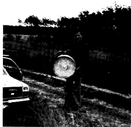
Anton, PAoADE, op de 'meetheide' met de Short Backfire antenne van PAoMJK in de hand.
